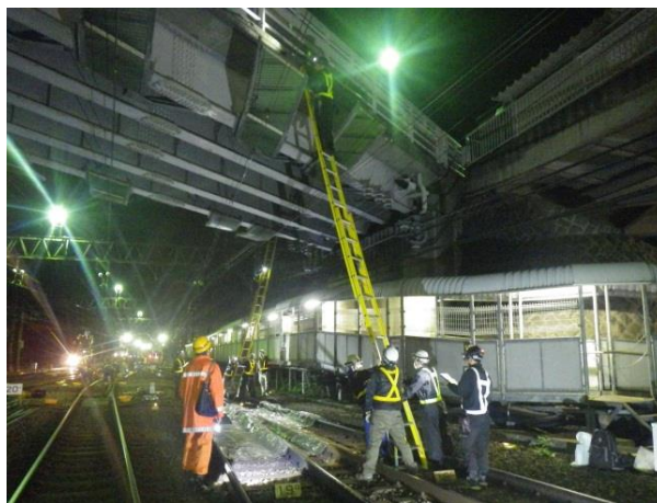
橋梁メンテナンス状況（軌道内）
