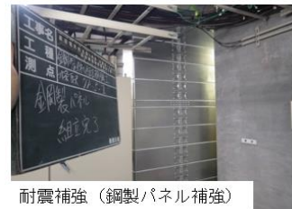
耐震補強 (鋼製パネル補強)
